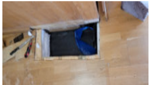
Öffnung des Bodens im Spiegelsaal mit Feuchtigkeitsmessung
