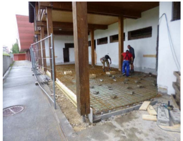
Hier entstehen die Räume für die TSV-Sauna
