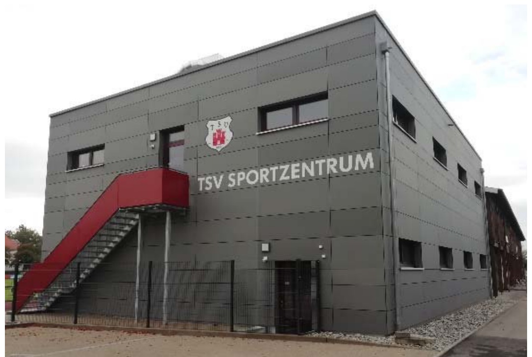
Fertigstellung und Eröffnung im Juni 2021
