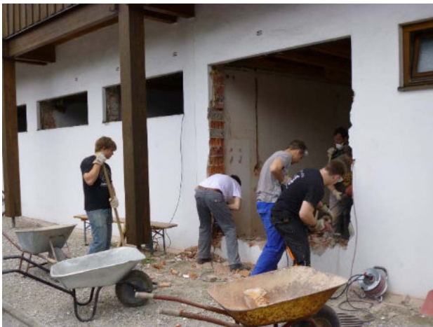
Durchbruch für den neuen zentralen Eingang
